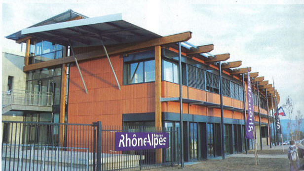
Le nouveau lycée à ossature bois de Chazelles-sur-Lyon (Loire) a été achevé pour la rentrée 2011.
